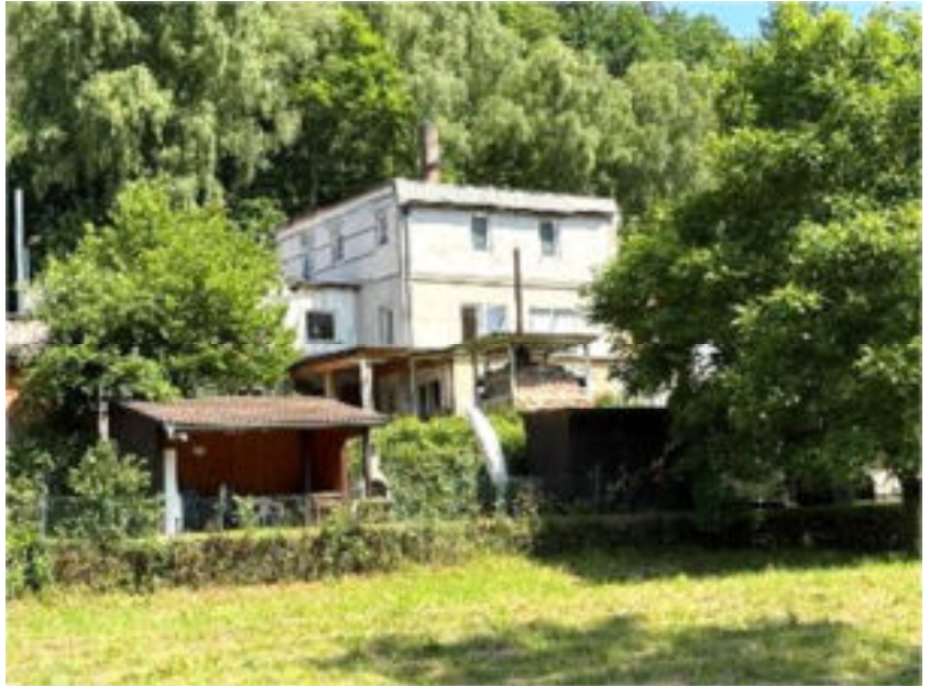
Foto 3 des SV: Ansicht von Südwesten, Rückseite
