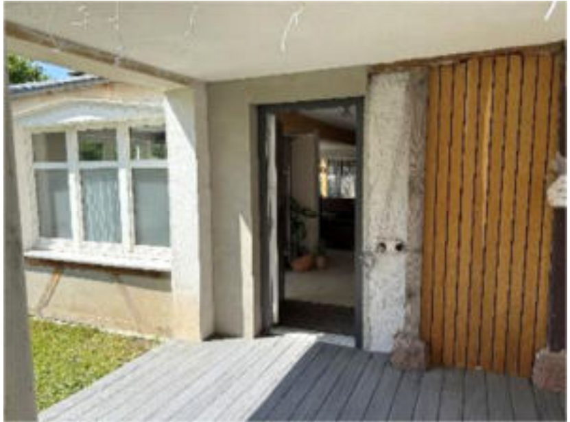
Foto 7 des SV: Hauseingang Wohnung 1 (UG)
