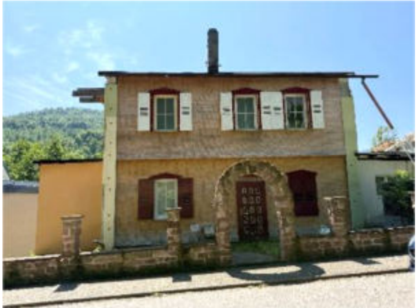
Foto 1 des SV: Ansicht von Norden, Straßenansicht
