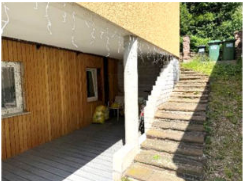
Foto 6 des SV: Zugang zur Wohnung 1 in UG/EG
