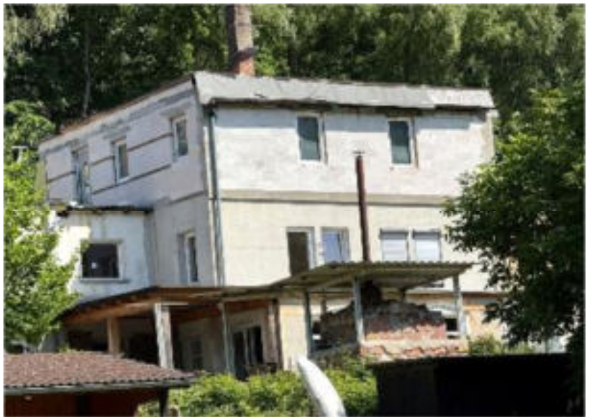
Abb. 3: Foto des SV; z.T. Fassade/Dach nicht fertiggestellt
