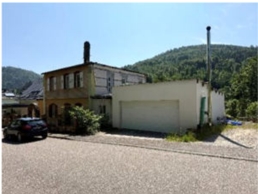
Foto 2 des SV: Ansicht von Nordwesten, von der Gernsbacher Straße
